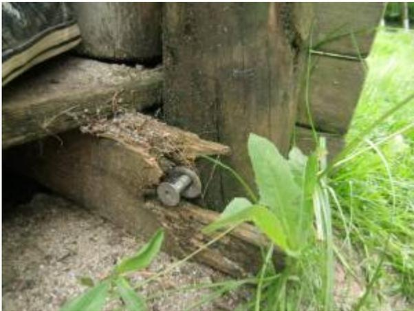
Ein echter Fall für eine Reparatur ist der Zug auf dem Spielplatz Kirchstrasse. Hier fehlen nicht nur Latten, sondern das Holz ist an einigen Stellen weggedorrt. Außerdem wackelt die Konstruktion schon.
