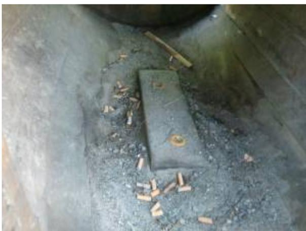
Das Fass (gerätetechnisch ein Tunnel) wird als Mülleimer missbraucht. Außerdem sind die Löcher zu klein.
